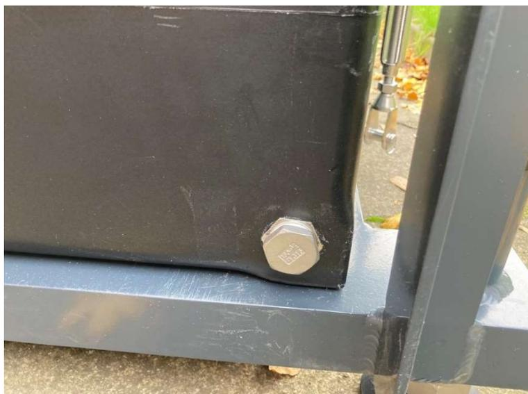
Figure 50. Le bouchon de vidange du réservoir de ballast.
