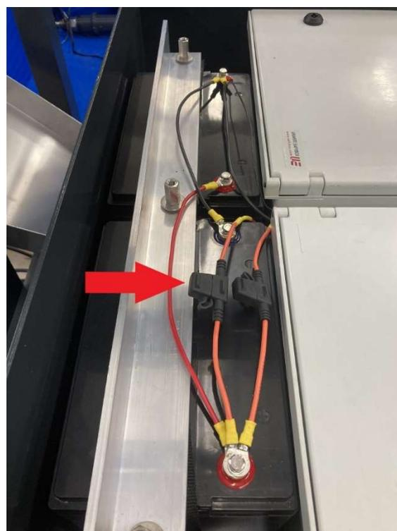
Figure 21. Batteries installées en configuration parallèle. Les porte-fusibles à mini-lame sont indiqués par la flèche rouge.
