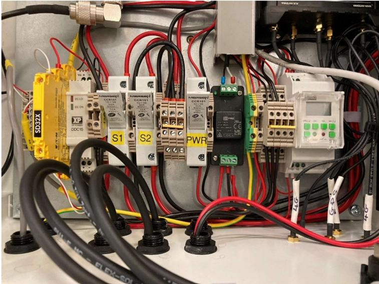
Figure 27. Les fusibles commutés de l'enregistreur en position ouverte.
